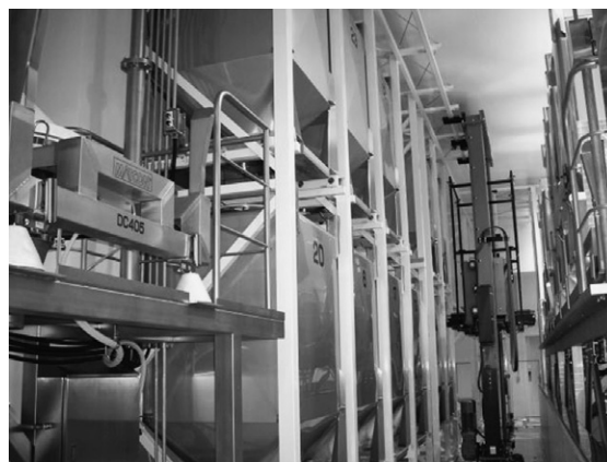
図-7 保管棚とスタックークレーン（STC）
